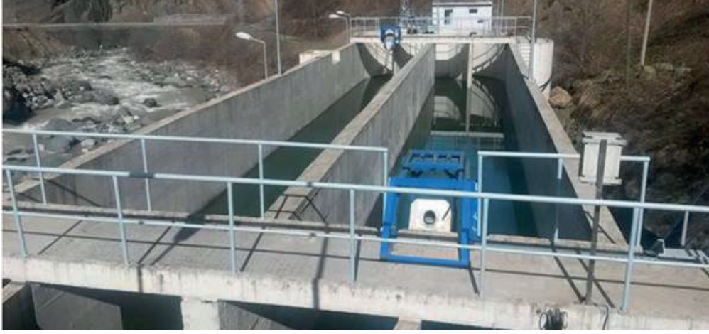
Tonya Biyolojik Atıksu Arıtma Tesisi
