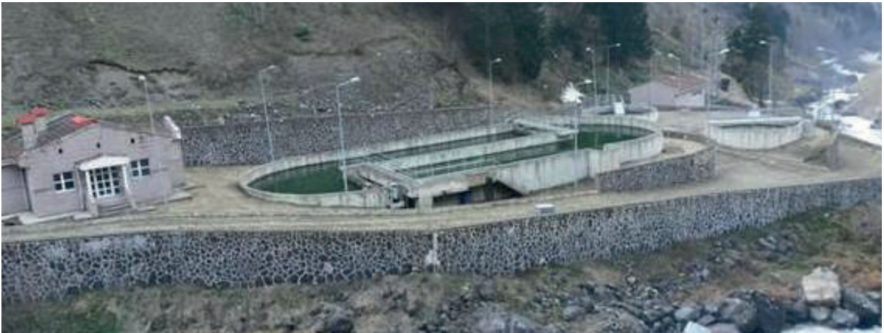
Çaykara-Uzungöl Biyolojik Atıksu Arıtma Tesisi
